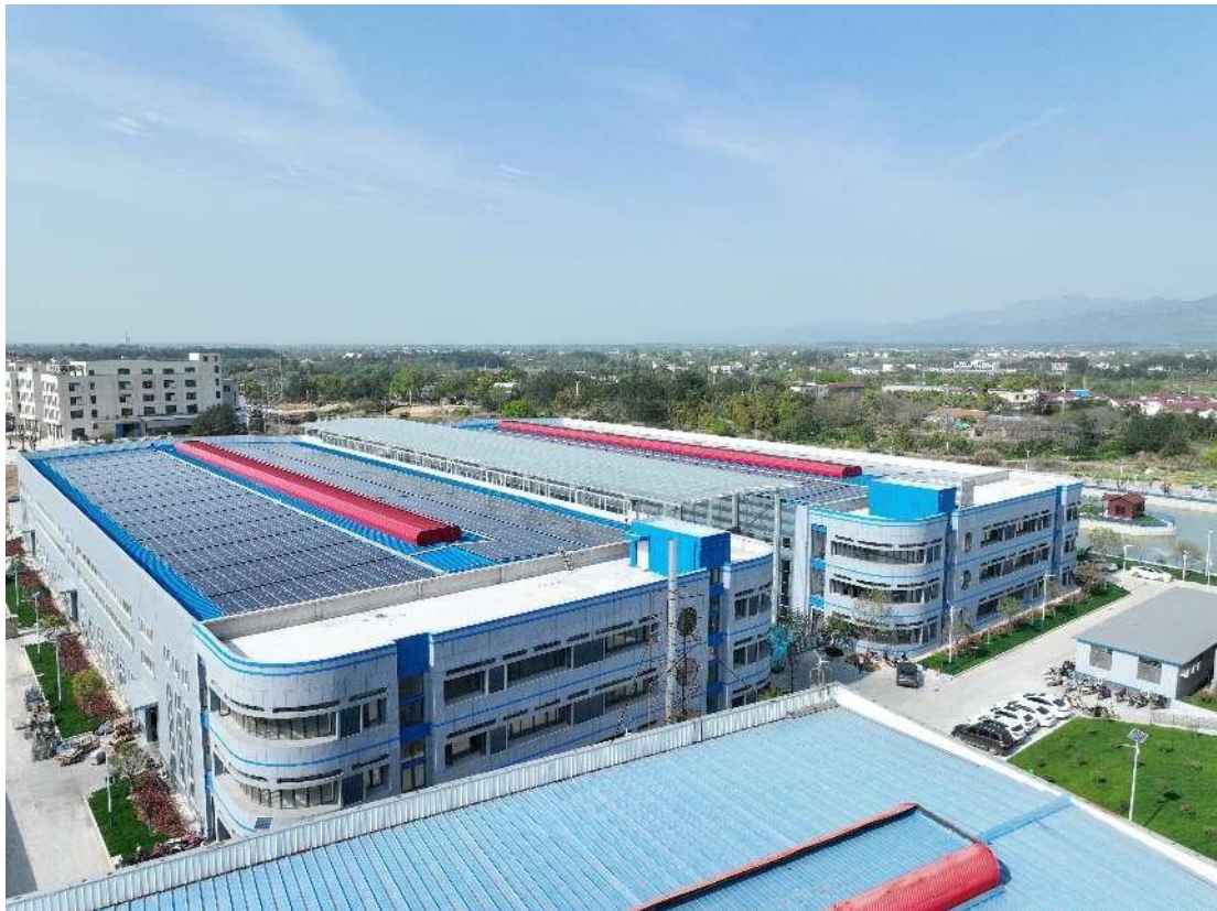
车间屋顶光伏发电
